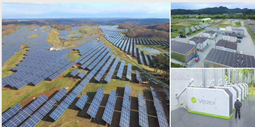
▲株式会社タクミ電機工業では電気工事から再生可能エネルギー事業まで幅広く展開
